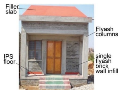
Figure 6. Rattrap Bond technique. ( NIRDPR, 2005 ).
